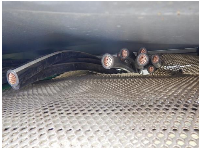
🔔 上記写真のように固い銅線が鋭利に切れ盗難されています。
